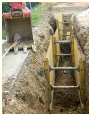
Izgradnja kanalizacijskega odseka Hmelina
