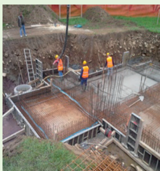
Izvedba ZB 3 in ČRP 6
