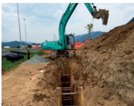
Izvedba kanala K1 (ob obvoznici)
