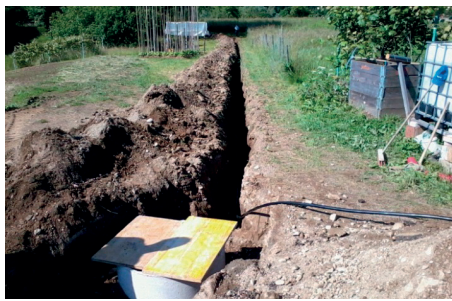
Izvedba nizko napetostni priključkov črpalšč ČRP 9 (Vas)
