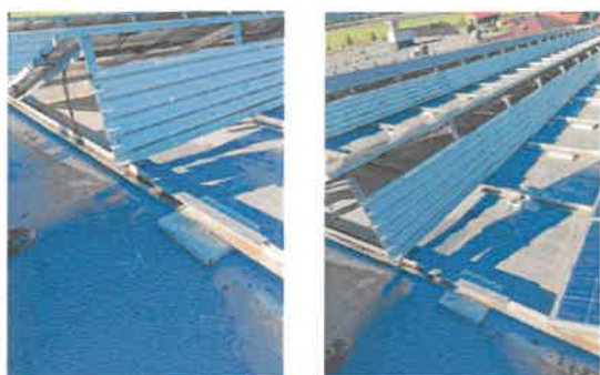
Slika 5: Pogled na streho objekta
