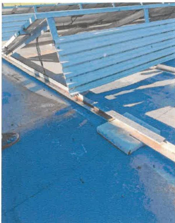
Slika 5: Pogled na streho objekta Športna hiša
