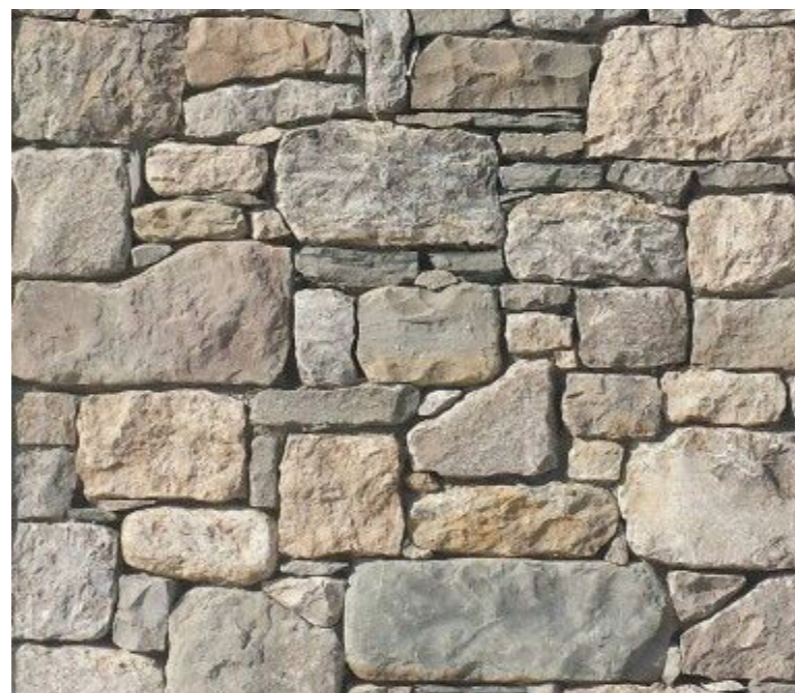
zid na S: kot kamnita zložba
