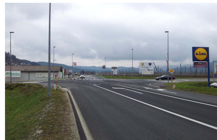
Slika 50: Pogled na obravnavano križišče iz Koroške ceste
