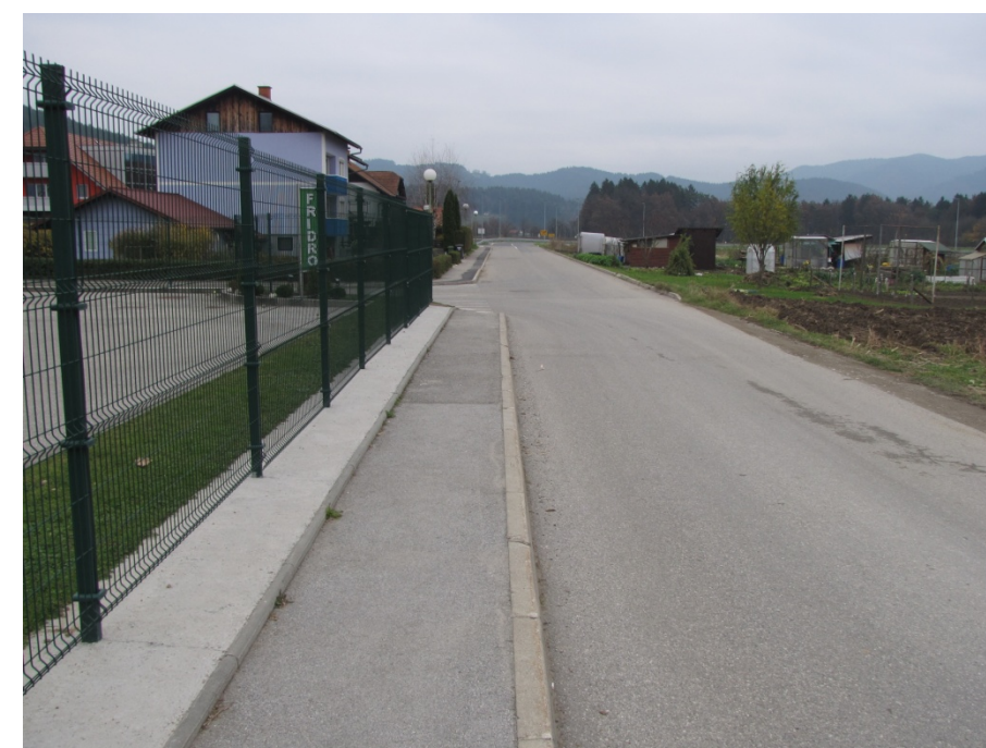
Slika 47: Pogled na obravnavano ulico iz smeri Pohorske ulice.
