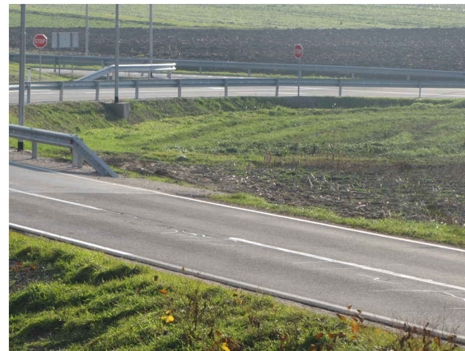
Slika 80: Pogled na obravnavano križišče iz Mariborske ceste.
