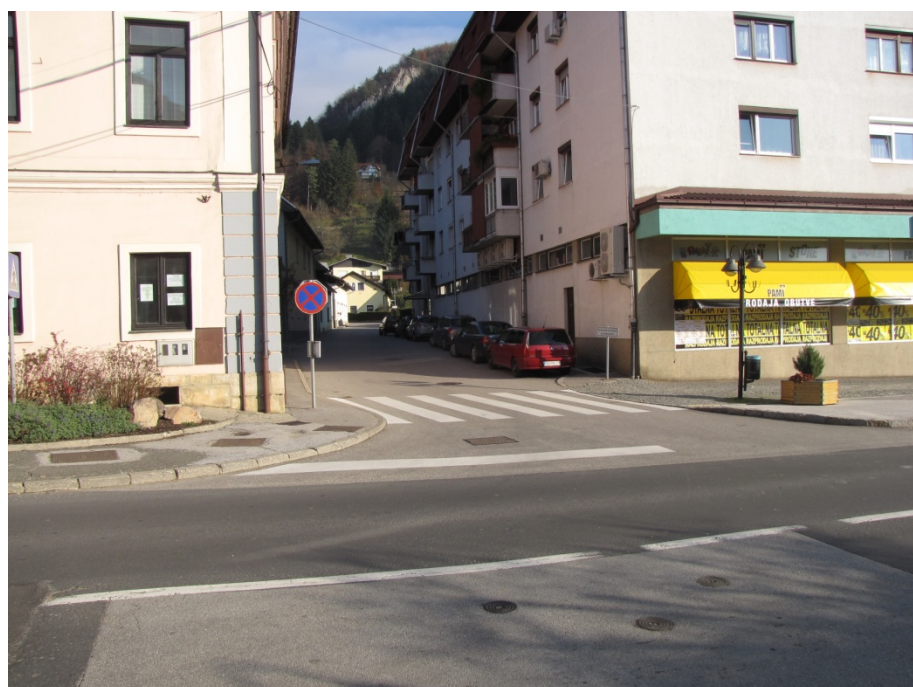
Slika 64: Pogled na obravnavano križišče iz Mariborske ceste
