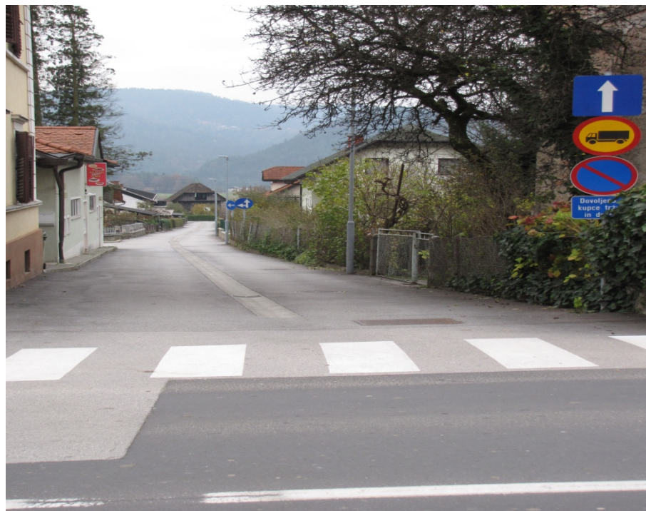
Slika 60: Pogled na obravnavano križišče iz Mariborske ceste
