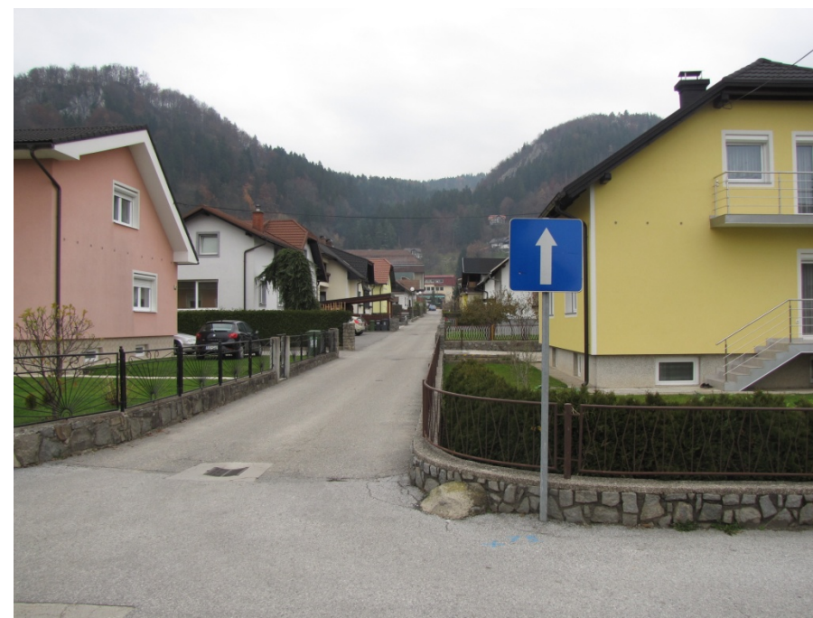
Slika 39: Pogled na obravnavano ulico iz Maistrove ulice.
