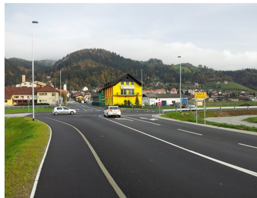
Slika 78: Pogled na obravnavano križišče iz Pohorske ceste.
