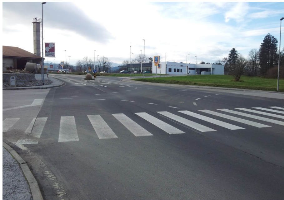
Slika 52: Pogled na obravnavano križišče iz Koroške ceste
