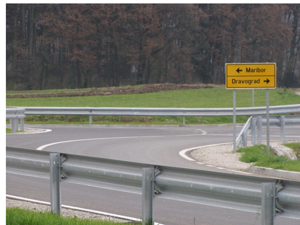
Slika 74: Pogled na obravnavano križišče iz Mariborske ceste.
